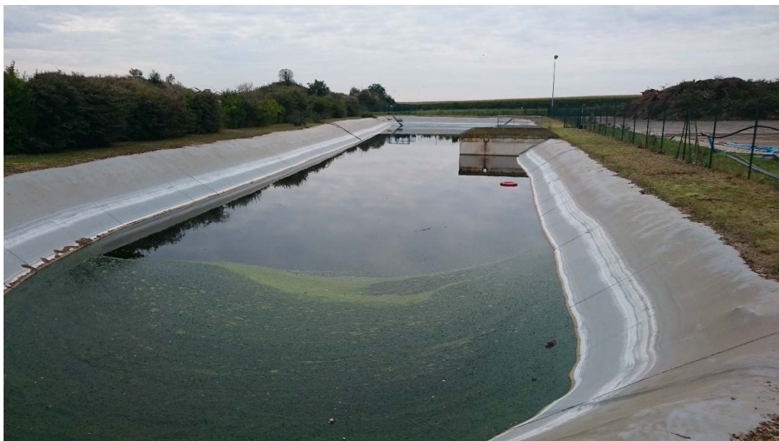
Lagune de stockage des lixiviats
